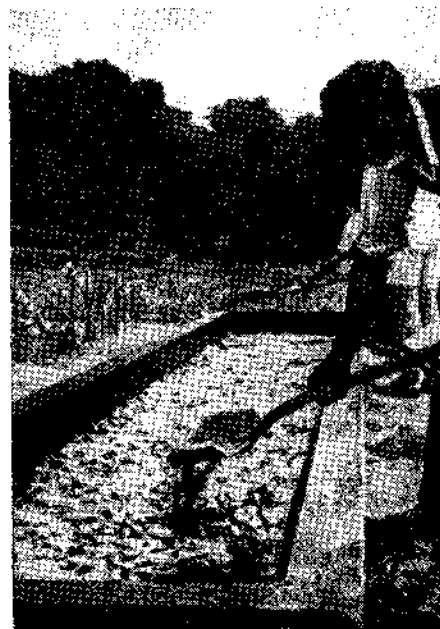
Рис. 75. На гравий осторожно насыпают промытый влажный речной песок.
