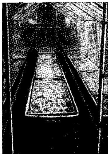
Рис. 97. В Йоркширской теплице (Англия) субстратом служит смесь песка с торфом. Поддоны металлические. Вокруг поддонов смонтированы обогревательные трубы.
